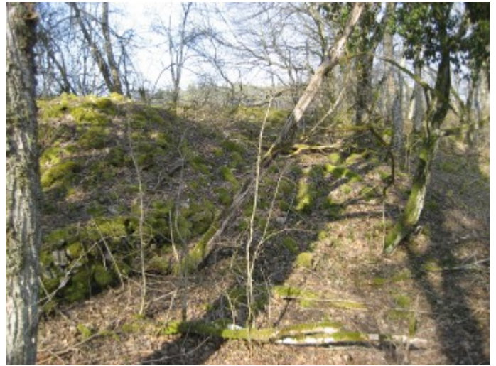
... der obere Teil der Mauer ist verschwunden, die Splittfüllung ist gut zu sehen. Hier geht ihr nördliches Ende in einen Steinwall über.
